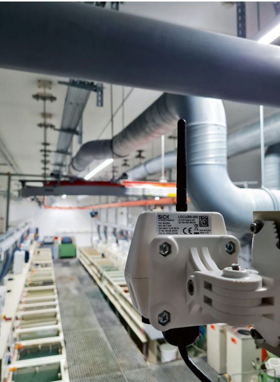
UWB-Antenne über der Trommelgalvanik.
