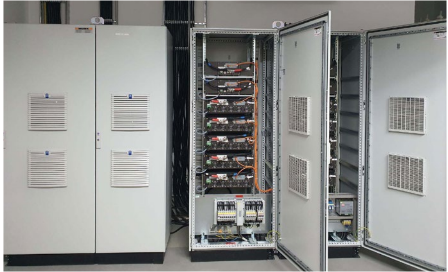
Sechs Kilometer Strom- und LAN-Kabel wurden verlegt, um die zuvor an jedem Bad einzeln angeordneten Gleichrichter in zwei Steuerschränken zusammenfassen zu können.
